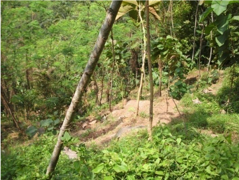
Gambar: Penguatan Lereng dengan Tanaman keras di Cibangkong
