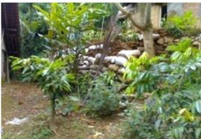
Pembuatan Talut dengan Bronjong
