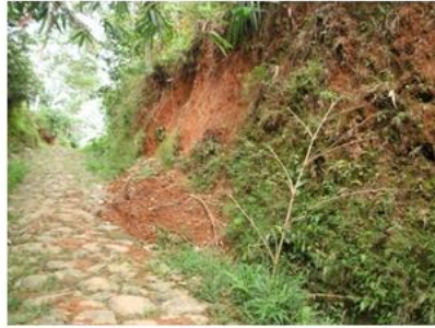
Pemotongan Lereng untuk Jalan di Desa Krajan
