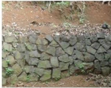
Pembuatan Talut dengan batu dan tidak di Semen
