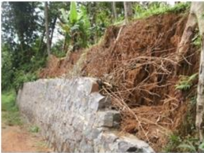
Pembuatan Talut dengan Batu dan Semen
